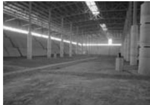
年間と予定しております。幅90m×長さ304mの大きさは圧巻です。深さ15m、地上部が高さ23mで、施設の底面、側面には遮水シート、保護マットが設置されています。建設費は35億7000万円で平成23年4月1日から供用開始予定となっています。
